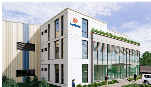
Nhà máy hóa chất xây dựng Bestmix
