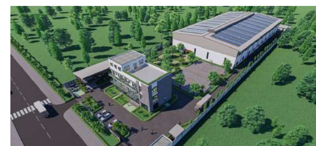
Nhà máy sản xuất đệm xốp ngành giày dép
