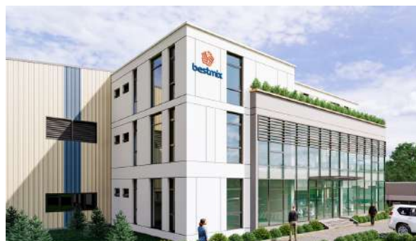
Nhà máy hóa chất xây dựng Bestmix
