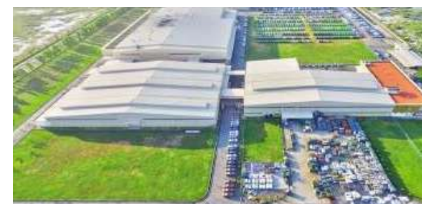
Nhà máy Nisshin
