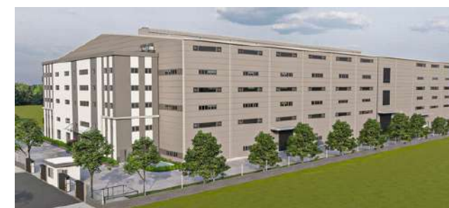
Nhà máy Việt Hưng Thịnh
