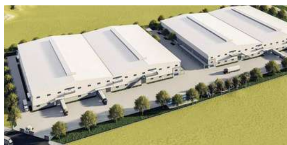
Nhà máy công nghiệp Sài Gòn Wicker
