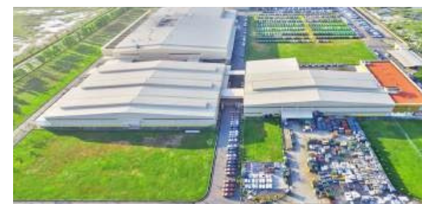
Nhà máy Nisshin
