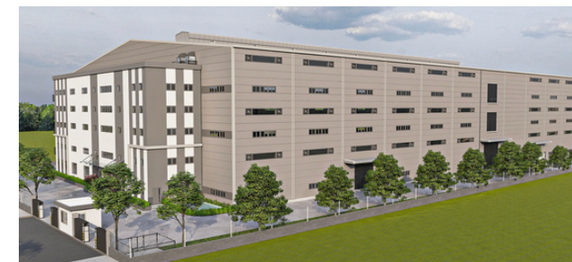
Nhà máy Việt Hưng Thịnh
