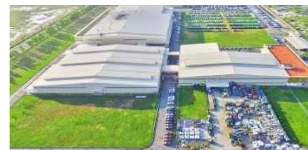
Nhà máy Nisshin
